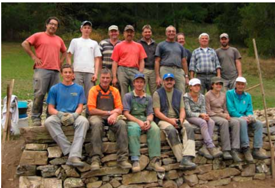
24 Meter Trockenmauer saniert: Die Teilnehmenden des Trockenmauerbaukurses im Oktober 2009.
